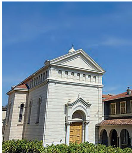
Les clarisses de Nice laissent leur place aux Petites Sœurs des Pauvres. Le couvent va être transformé en projet d'habitat pour les personnes âgées à faibles ressources.
